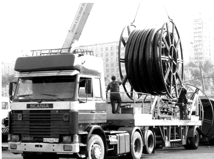
Рисунок 3.2 – Погрузка ГПИ-труб на барабанах
