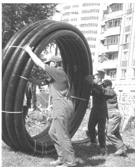
Рисунок 4.3 – Размотка ГПИ-труб, поставляемых в бухтах
