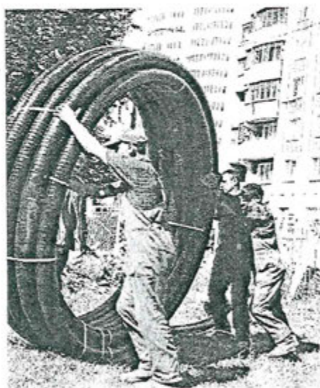
Рисунок 4.3 – Размотка ГПИ-труб, поставляемых в бухтах
